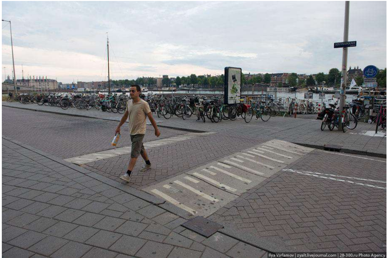
Рис.3.17.5 – Пример устройства пешеходного перехода на уровне тротуара. Зарубежная практика (пешеходный переход в Амстердаме).
